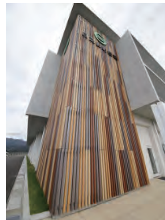
外牆壁面 (仰視)
